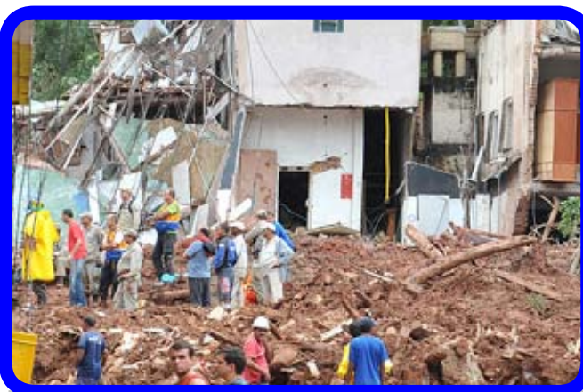
リオ水害被災地 ノーバ・フリブルゴ
